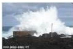
A OWC consiste numa câmara com uma abertura para o mar abaixo do nível da água. A entrada e saída de água faz com que a pressão no interior da câmara seja alterada. O movimento do ar é usado para accionar uma turbina de ar accionada a um gerador eléctrico. Este tipo de aplicação pode ser encontrado nos Açores.
