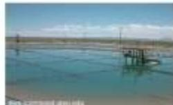
Os **lagos solares** são um reservatório de água capaz de captar e armazenar energia solar para posterior utilização sob a forma de energia térmica. As suas aplicações vão desde o aquecimento de estufas, estufas, piscinas até à utilização em processos de dessalinização e purificação de sais. Pode ainda ser utilizado em aquicultura.
