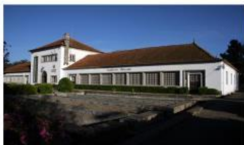
Edifício principal da Estação Aquícola
